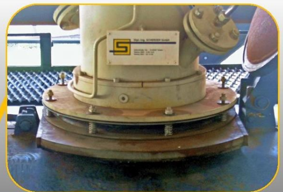
B) Federnd gelagerte Dichtplatte (äußere Domabdichtung)
