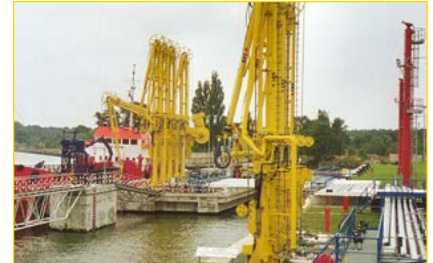
Schiffs Belade- und Entladesystemen Ship loading- and unloading systems Системы слива-налива танкеров
