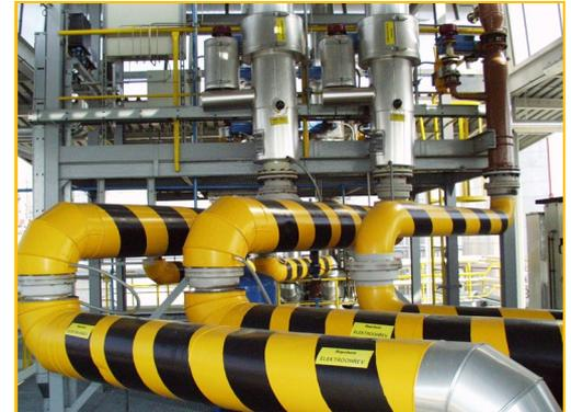
Unsere On-Spot-Beladeanlagen für die Befüllung schienengebundener Fahrzeuge mit Flüssigprodukten wurden für große Abfüllleistungen entwickelt. Über Füllrohre bis DN 300 sind Ladeleistungen bis 1.000 m<sup>3</sup>/h und Ladestelle (Füllposition) möglich. Dabei können verschiedene Produkte an einem Punkt verladen werden. Zur Bedienung einer Zweigleis - Beladeanlage mit z.B. 20.000 to./Tag Ladeleistung, sind nur ein bzw. zwei Operator in der Meßwarte sowie ein bis zwei Hilfskräfte erforderlichlich.
